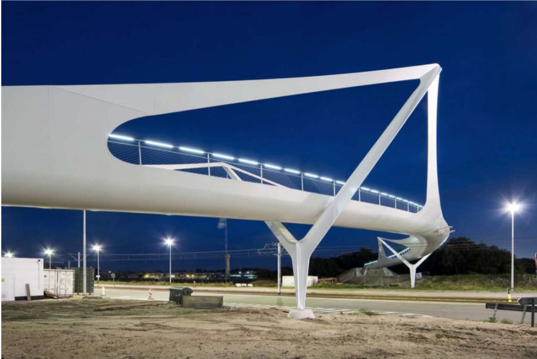
Laurent Ney: Fussgängerbrücke Knokke, Knokke-Heist, Belgien. 2007
