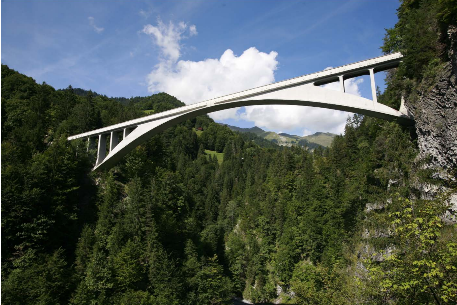
Robert Maillart: Salginatobelbrücke, Schiers, 1930
